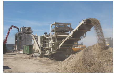
Mobiler Brecher für Bauabfälle
