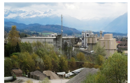
Kies-, Beton- und Belagswerk
