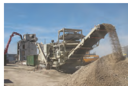
Mobiler Brecher für Bauabfälle
